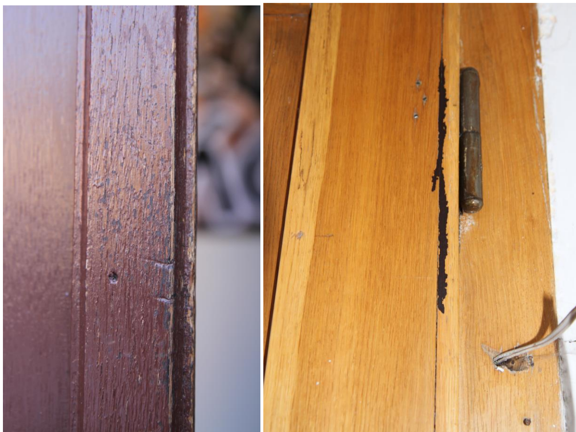
Detaily spodní vrstvy tmavého nátěru na vnější straně vstupních dveří a jeho fragmenty (patrně zateklé) na jejich vnitřní straně
