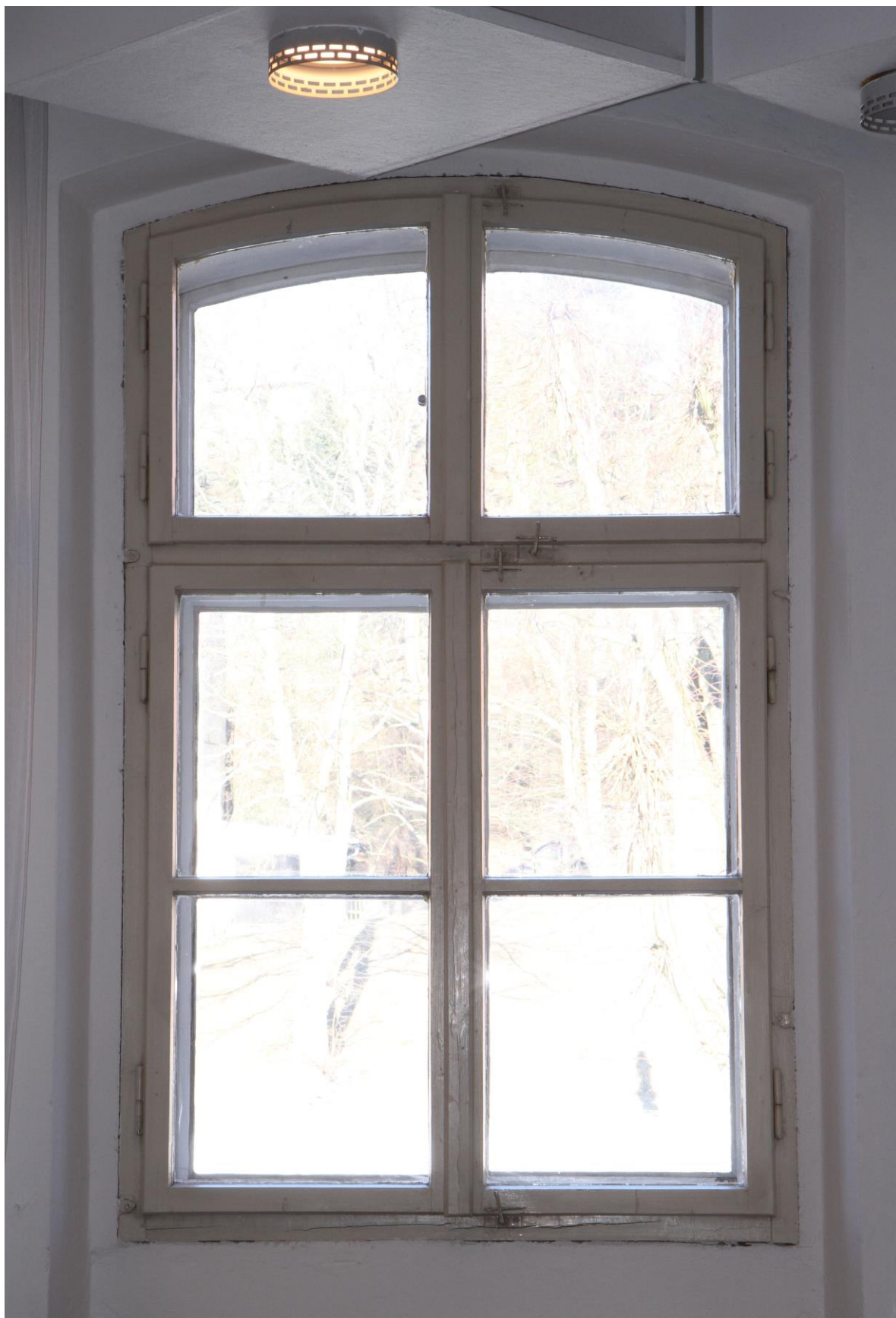
Okno ve 2. NP s druhotně vyměněnými vnitřními křídly a novodobými obrtlíky
