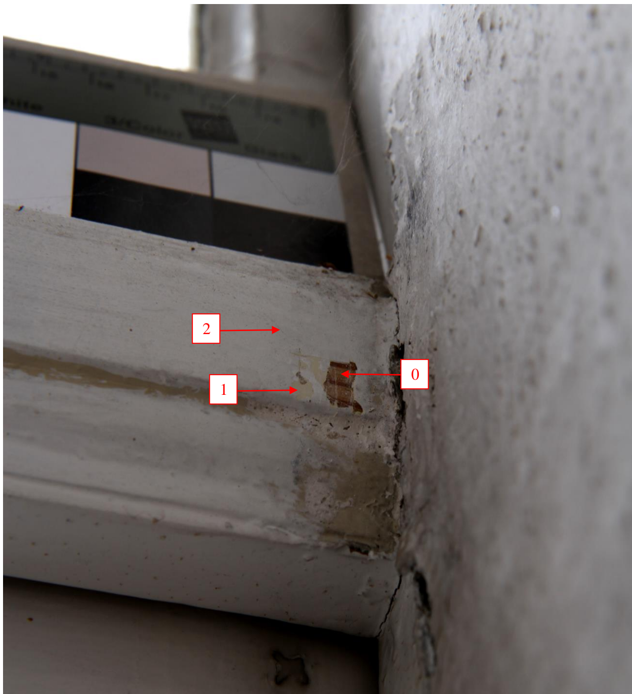
Průzkum barevnosti na poutci, který byl patrně v minulosti očištěný: 0 – povrch dřeva, 1 – žlutookrový nátěr, 2 – současná lomená bílá
