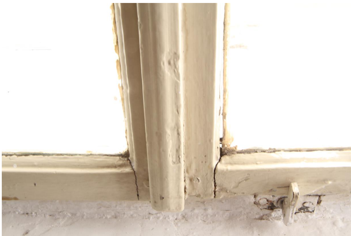
Detaily rozvolněných spojů a spojů zpevněných rohovníky
