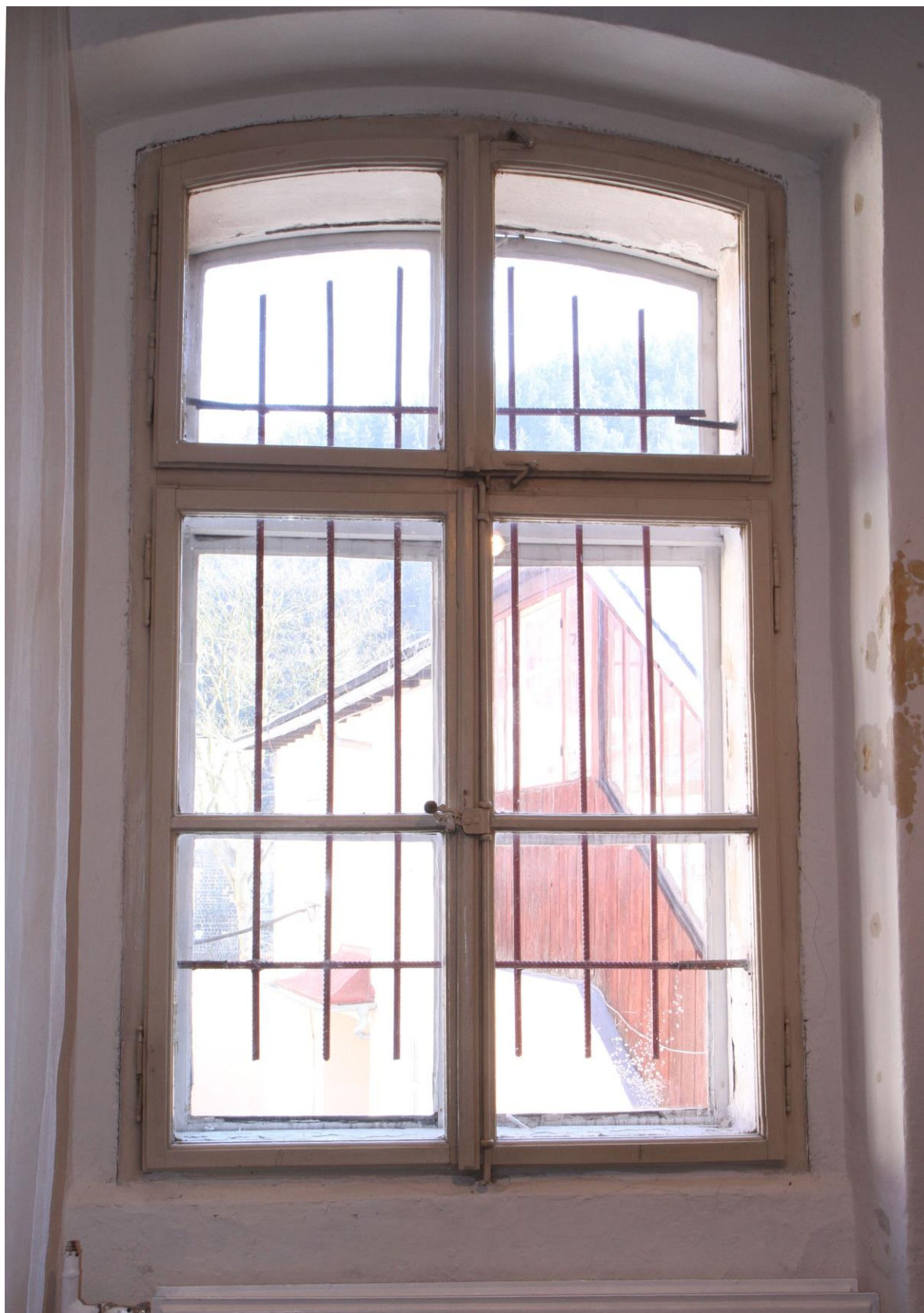
Okno ve 2. NP s dochovanými původními vnitřními křídly a espaňoletou
