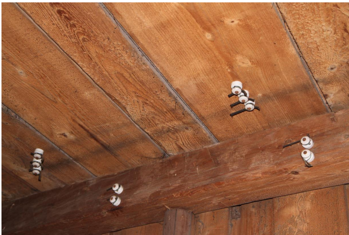
Zbytky staré elektroinstalace
