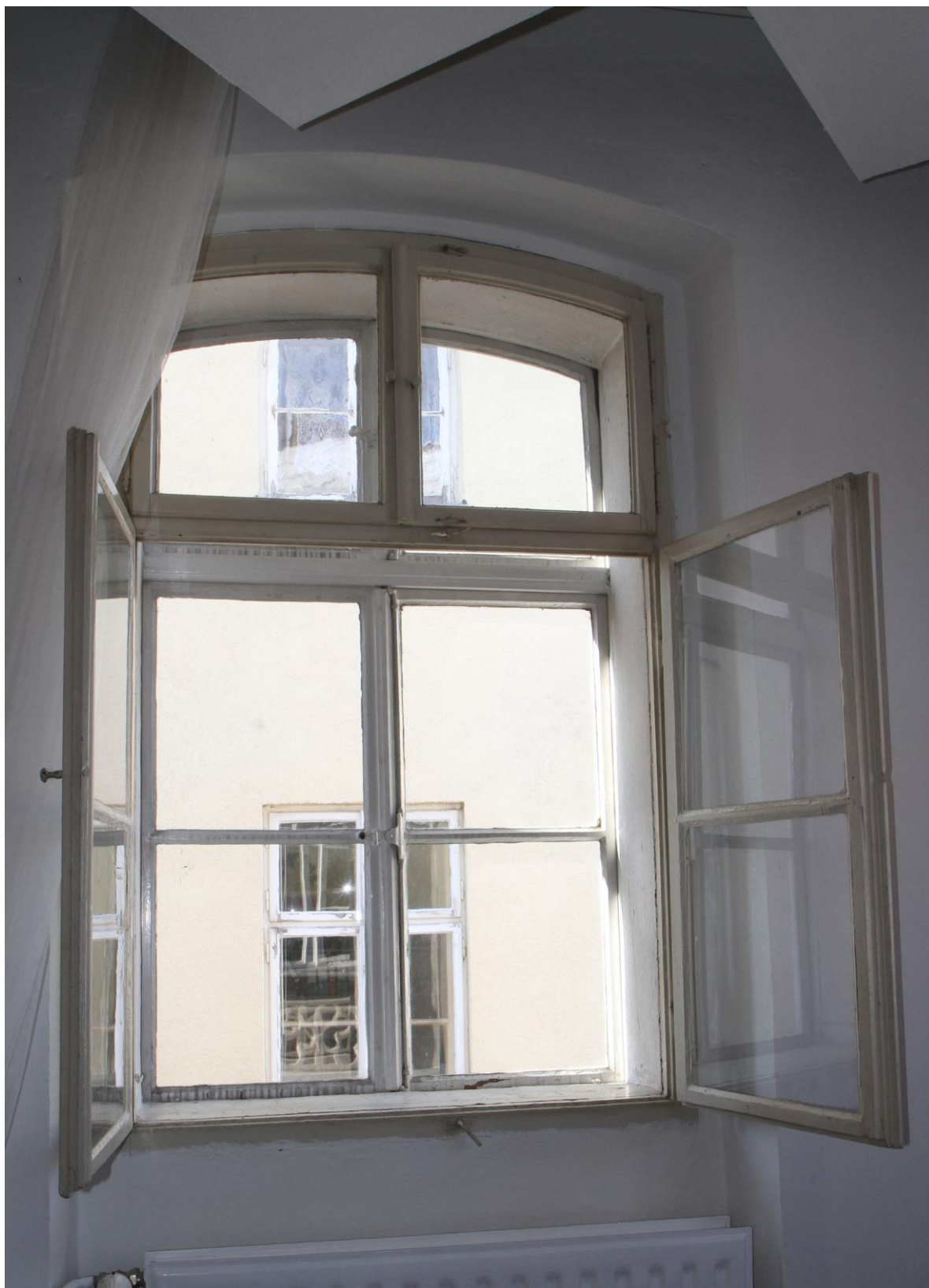
Okno ve 2. NP se zavíráním vnějších křídel na españoletu a kruhovými úchyty na vnitřních křídlech
